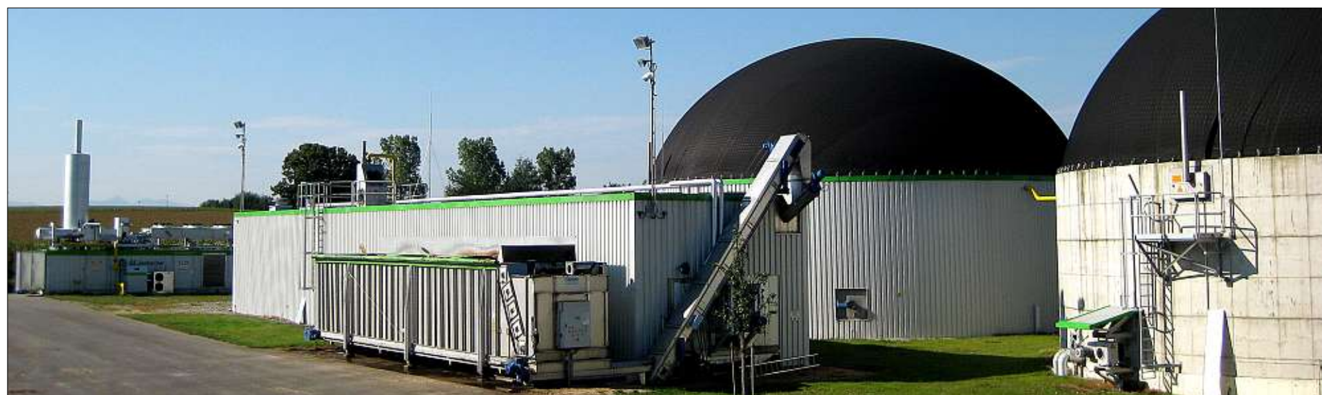
Die Biogasanlage in Feichten läuft seit 2006 nicht nur als Vorzeigebetrieb, sondern leistet jährlich bis zu 6000 Megawattstunden Strom und versorgt mit der Abwärme zehn öffentliche und 65 private Gebäude sowie eine Maistrocknungsanlage mit Wärme. Im Frühjahr war sie Ziel einer Exkursion polnischer Landwirte und Kommunalvertreter unter Leitung von „Bayern international“ und der TUM Tec GmbH München.
