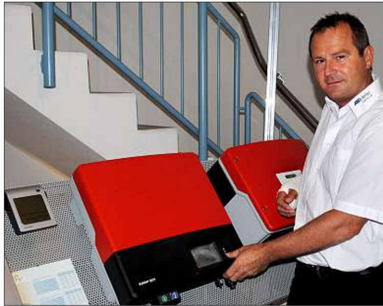
Wichtig seien auch die Details in einer Anlage, so zum Beispiel die Wechselrichter, sagt Roland Huber. Da eine Photovoltaik-Anlage Gleichstrom produziert, wird ein Solar Wechselrichter benötigt, um diesen in Wechselstrom umzurichten. Bei den Wechselrichtern sollte keinesfalls an der Qualität gespart werden.
